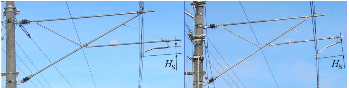
Рис. 7. Различные значения параметра H_S на опорах одного анкерного участка (перегон Саблино–Тосно Октябрьской железной дороги, реконструкция 2006 г.)
